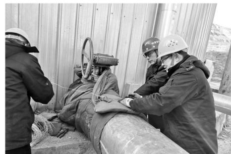
为加强安全生产管理,保障设备安全过冬,神渭管运生产运行公司加大巡查力度与频率,并利用废旧物资对泵房、管线、阀门、仪表等不同主体,采取了最优的防冻措施,严防冻结冻凝事故发生。于小强 贺换换 摄
