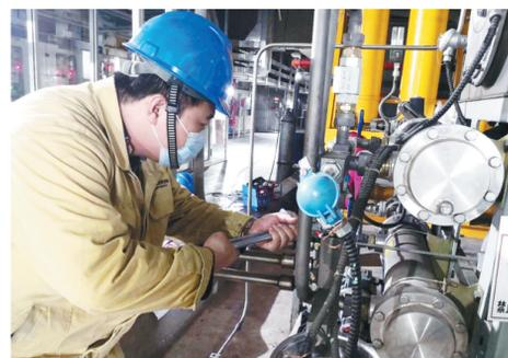
近日，国家能源集团国华锦界电厂组织开展6号机EH油站油管改造工作。EH供油装置主要功能是为各执行机构提供所需的液压动力，同时保持液压油位的正常理化特性。
