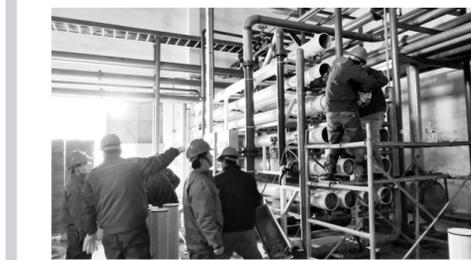
修旧利废,节能降耗,是陕化公司长期提倡和积极践行的理念。1月初,该公司动力厂对一批反渗透膜进行再利用,开创2021年成本管理新业态。据悉,这批反渗透膜在中水岗位安装运行后,膜间压力明显下降,运行良好,保证反渗透运行增加至少一年。 鲁锦涛 摄
