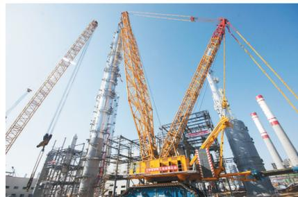
2月10日上午8时58分,榆林化学净化装置低温甲醇洗A系列变换气洗涤塔(T101)缓缓起吊,11时56分,设备安全就位,标志着该公司2月份又一个“追赶超越”节点目标顺利完成。本次吊装的变换气洗涤塔(T101)是该公司净化装置低温甲醇洗单元的核心设备,设备总重830吨,塔高89.6米,是项目建设现场最高、最重的设备。姚渊 摄
