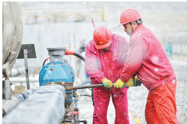
2月25日,“倒春寒”天气来袭,给鄂尔多斯盆地油气生产带来严峻挑战。面对突如其来的恶劣天气,长庆油田五大主力气田齐头并进,天然气平均日产量保持在1.4亿立方米以上。 □薛涛 阳忠华 侯健 摄
