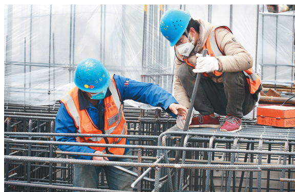
2月23日,在陕建安集团高新天谷雅舍项目,工人们正在进行焊接防雷接地施工。据了解,该项目作为西北地区第一个被动式低能耗社区,总投资11.7亿元,总面积137149.23平方米。 □王诗萌 摄
