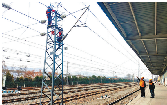
近日,中国铁路西安局集团有限公司宝鸡供电段在元宵节前,完成社棠车站48根15米高的接触网钢柱的除锈、涂漆工作,保证供电设备安全可靠,确保旅客列车供电安全。 □张赢弘 摄
