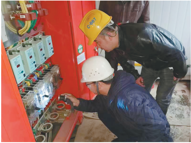
日前,陕建九建集团承建的省十七运项目、省市级重点项目,以及春节不停工项目,以复工复产安全专项检查为抓手,多措并举保障在建项目迅速进入工作状态,尽快掀起大干热潮。图为基层安全管理人员进行专项检查。 □南引练 摄
