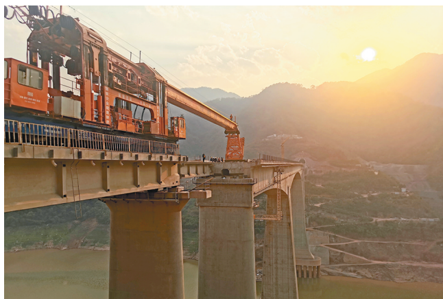
3月3日,随着32米T梁缓缓落在桥墩上,中老铁路国内玉磨段的阿墨江特大桥开始架梁,标志着铺轨架桥已进入云南省普洱市墨江县境内。阿墨江双线特大桥全长617米,其中主跨为216米的连续钢结构梁,是全国同类跨度最大的铁路桥。 □刘顺良 摄
