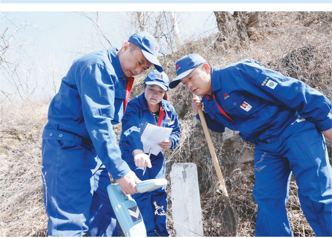
日前,延长石油管道公司针对春季解冻的特点,抓早动手,对2300余公里管线全面开展地质灾害专项大排查工作。对发现的河道穿越、滑坡等影响管道安全运行的隐患立即进行整改治理,为开春土壤解冻管道运行提供安全保障。
