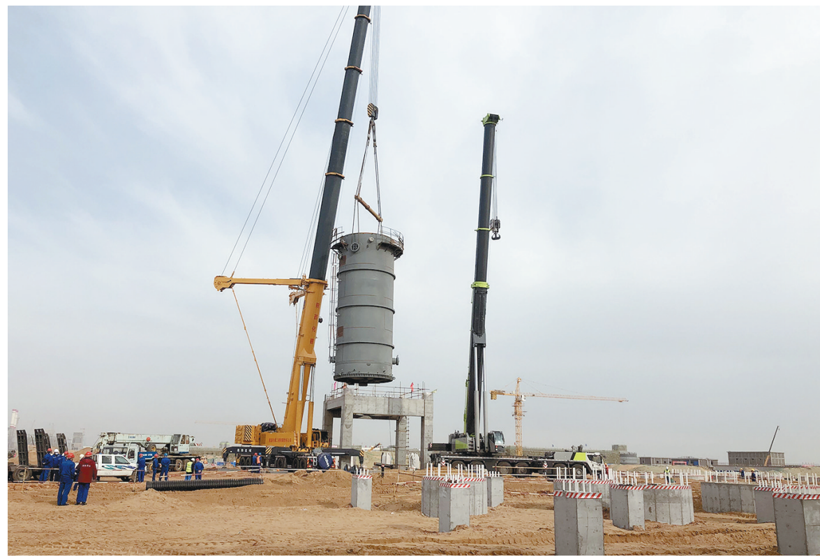
进入3月份以来,陕西化建承建的榆神50万吨/年煤基乙醇项目现场设备陆续进场,迎来安装施工高峰期。3月13日,该项目超限设备第一台超限塔器顺利运抵施工
