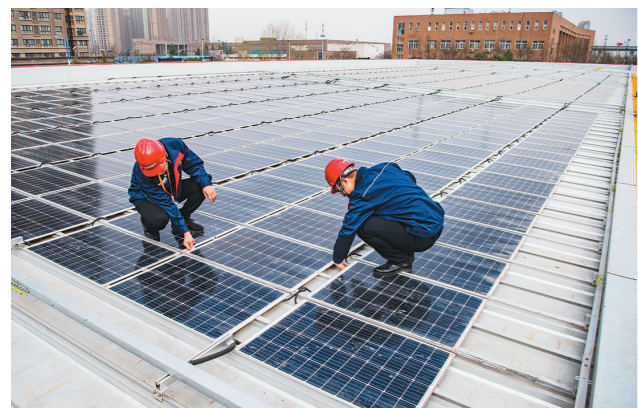
3月24日，在陕西汤姆森电力科技有限公司厂房屋顶上，工作人员巡视屋顶建筑光伏一体化(BIPV)项目。据了解，该厂房已投入使用8年，漏雨、破损给企业生产、安全带来诸多不便，经过隆基的方案设计，在不影响企业正常生产运营的前提下，使企业实现屋顶翻新改造和清洁能源电力长效绿色发展两不误。 □袁全寿 摄
