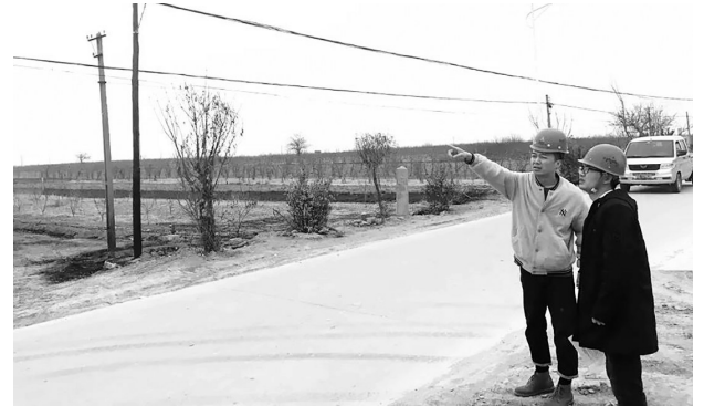
为确保管道主体及光缆通讯安全,切实了解掌握基层人员工作情况,近日,神渭管运公司外协抢修中心对沿线3个巡护队、1个光缆技术队进行安全检查,为今后各项工作开展打好安全基础。 樊恒 摄
