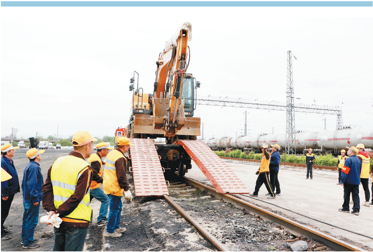
4月14日,中国铁路西安局集团有限公司陕南片区防洪演练在安康东站货6线举行,安康车务、机务、供电、工务、车辆及电务段等片区单位80余人参加。通过演练,有效提高了安康片区
