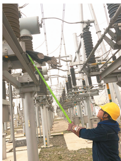
近期,为应对陕北沙尘大风天气,国网陕西省电力公司榆林供电公司积极采取措施,保障电网安全。图为4月18日,变电运维中心员工武刚清理330千伏绥德变电站1号开关B相电流互感器瓷瓶处悬空异物。 □刘玮 摄
