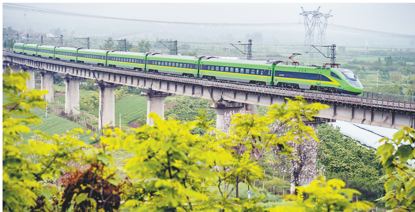
4月26日,一列Y778次“东方红号”旅游列车驶过秦岭北麓的西康铁路二线河滩大桥。
