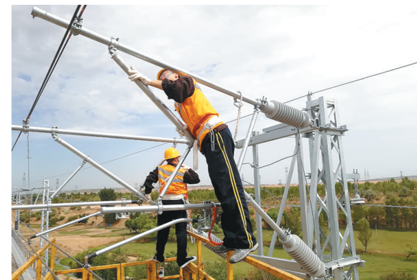
近日,中国铁路西安局集团有限公司延安运营维修段以站区为单位,组织开展防洪应急演练,对材料配件、工具设施等进行全面检查,确保迅速响应、快速处置。 □贺鹏 摄
