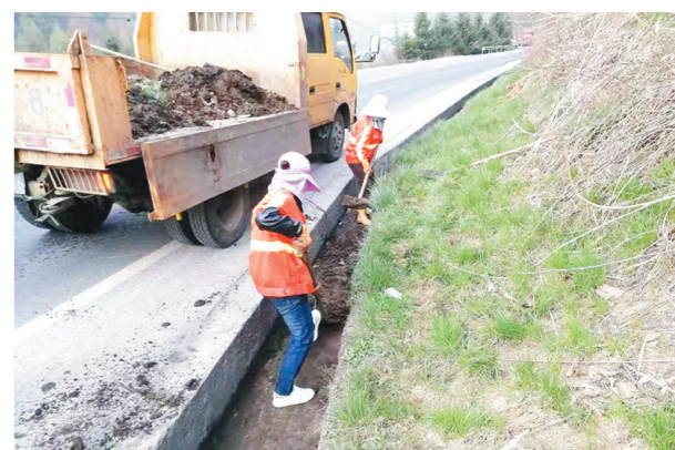
近期,太白公路管理段抓住晴好天气,疏通清理涵洞、水沟、泄水孔和伸缩缝,确保汛期来临前排水畅通。 □贾艳艳 摄
