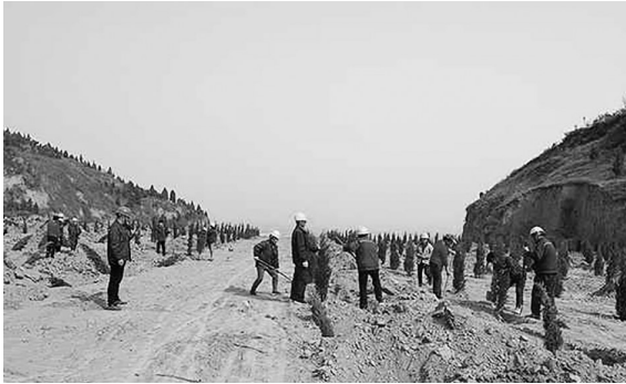
“辛苦了快一个月,栽了1500棵侧柏,看看这阵势,壮观不壮观。”近日,在渭化公司南塬上的渣场里,一大片新植的侧柏林令人赞叹。据悉,该公司常态化从清扫、围挡、降尘、绿化等方面对渣场进行综合治理,在平整后覆盖的新土层上共植侧柏1500棵。 刘进 摄
