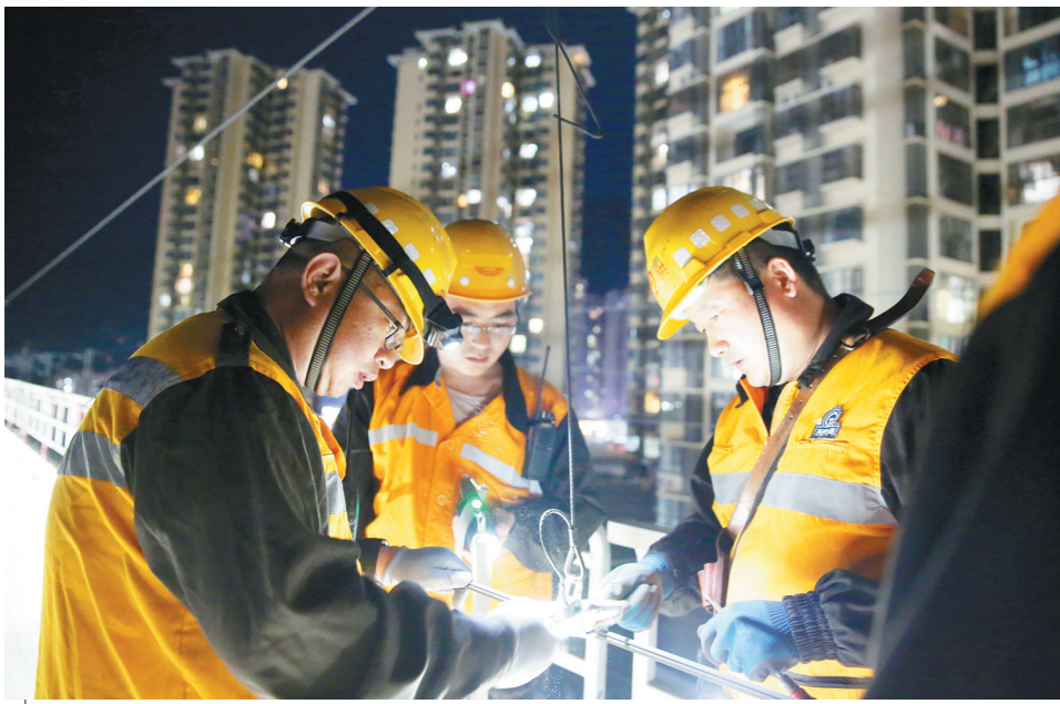
近日,中国铁路西安局集团有限公司宝鸡供电段组织团员骨干力量60余人,积极支援为期50天的“蒙渝线”设备整治“大会战”。该段从方案制定、人员培训、作业分工、车辆运输、
