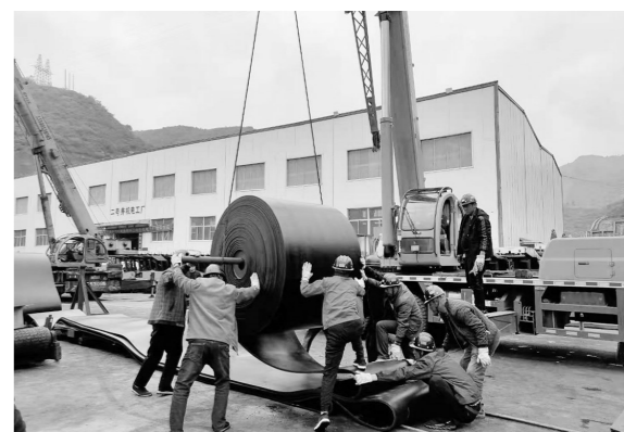
日前,建设集团韩城分公司安装四项目部严把工程安全、质量和进度关,铸造精品工程,承建韩城矿业桑树坪二号井主斜井胶带更换工程仅用72小时完成检修任务,受到了矿方好评。朱广存 摄
