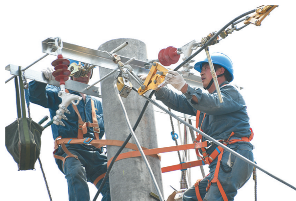
为彻底解决西安市临潼区仁宗山区用电最后一公里问题,近期,国网西安供电公司对该地区的电力基础设施进行改造,现已全线通过农网升级改造,线路全部绝缘化,跌落式熔断器、金具和横担全部焕然一新,提升了供电质量。 □潘世策 摄
