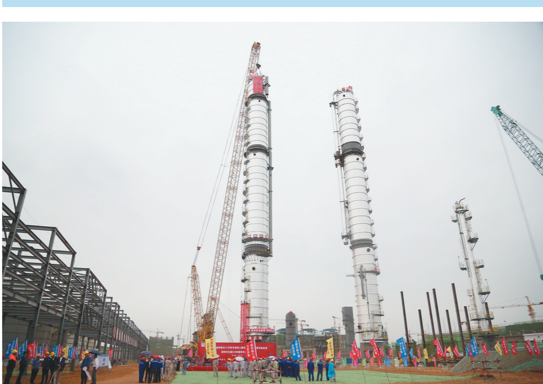
6月8日,陕西化建公司延长石油榆林能化50万吨/年乙醇项目,隆重举行购置800吨履带吊交车仪式,并对该项目最高、最重、直径最大的精制塔设备最后一阶段成功进行了吊吊封顶。该设备直径8米、高118米、总重
