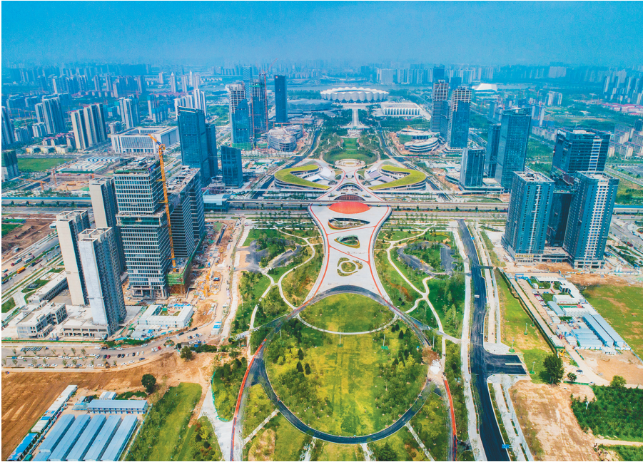
7月22日,航拍正在建设中的中欧班列(西安)集结中心中央商务区、港口功能区项目。据了解,中央商务区总投资780亿元,港口功能区总投资150亿元。 袁景智 摄
