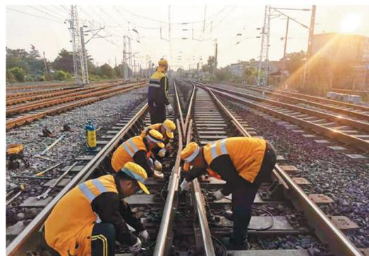
近日,中国铁路西安局集团有限公司西安工务段管内突发强降雨,该段团委迅速成立青年突击队,对线路设备、路外环境进行巡查整修,确保行车设备安全稳定。图为华山线路车间罗敷工区青年突击队队员,在桃下站东岔区进行更换叉心作业。 □马小妹 摄
