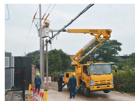
8月5日,国网西安供电临潼公司施工人员冒着39摄氏度的高温为陕西临潼特种玻璃有限公司安装供电设备。
