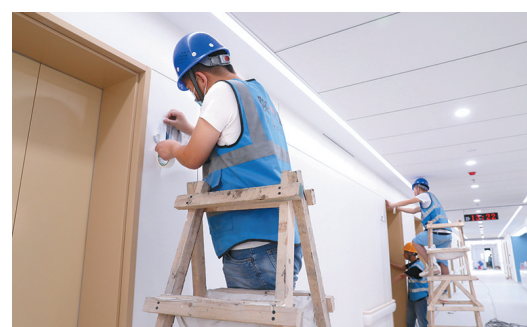
近日,由陕建三建集团承建的西安市红会医院高铁新城院区一期项目住院楼五层样板区进入收尾阶段。图为施工作业人员正在进行样品保护和现场清理工作。 □刘祥胜 摄
