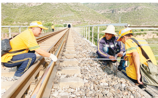
近期,中国铁路西安局集团有限公司延安工务段在全段范围内开展为期一个月的秋季设备大检查、大整治活动,全面排查线路、桥梁、隧道等病害,全力保障管内设备稳定和行车安全。图为8月18日职工在进行桥梁偏心数据测量。 □师延换 摄
