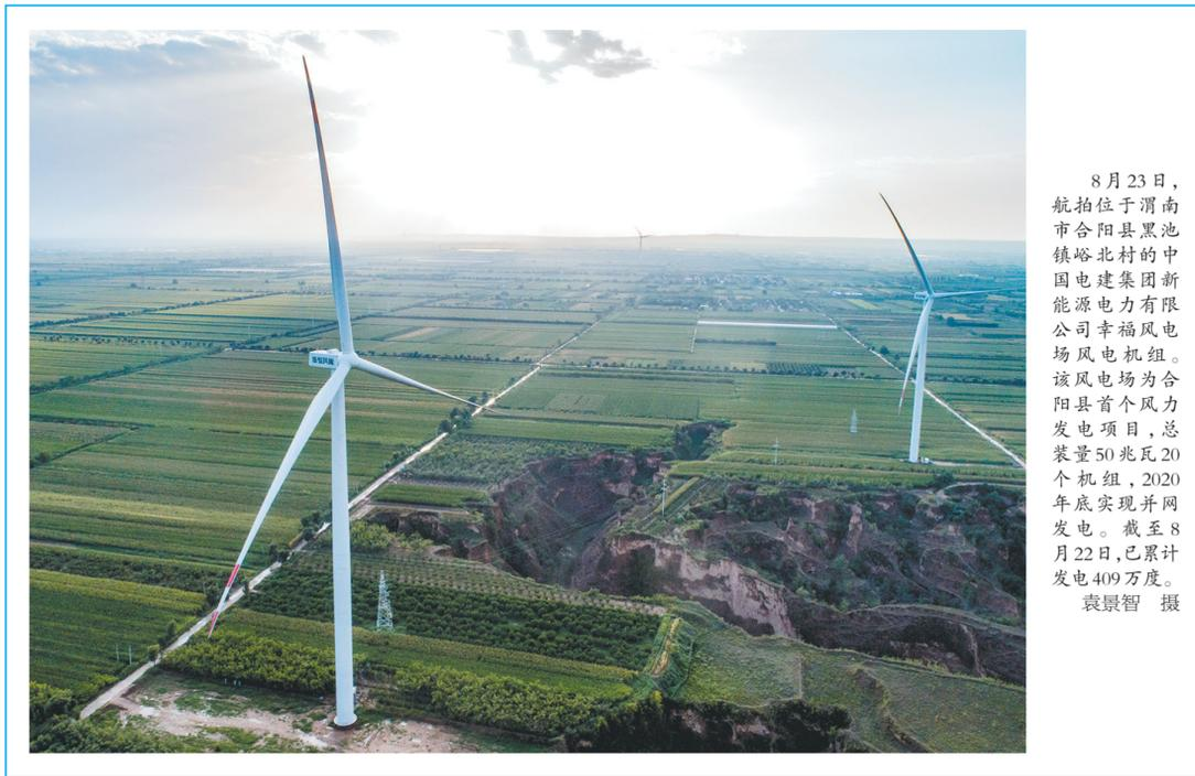
8月23日,航拍位于渭南市合阳县黑池镇塔北村的中国电建集团新能源电力有限公司幸福风电场风电机组。该风电场为合阳县首个风力发电项目,总装机容量50兆瓦,2020年底实现并网发电。截至8月22日,已累计发电409万度。 袁景智 摄
