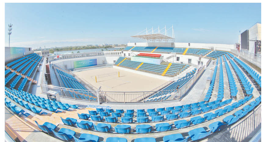
8月18日,渭南市大荔沙苑沙滩排球馆已做好准备,静待比赛到来。该馆旨在借力十四运会沙滩排球项目,融合“体育+旅游”,助推旅游产业发展。李仕居 杨陆涛 摄
