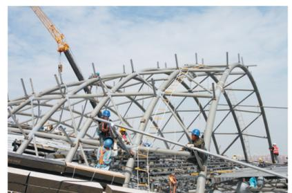
由中建五建集团承建的十四运会配套项目长安书院,建筑面积15.7万平方米。进入8月以来,工人们顶烈日加紧施工,确保按节点完成任务。图为工人焊接瞭望台钢架。王雄文 杨静 摄
