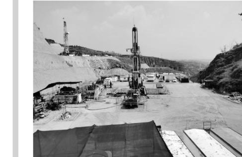
近日,由煤层气铜川分公司雪梅钻井队负责施工的《山西省三交地区煤层气合作项目》SJ86-H1井正式开工。此井为该分公司实施走出去战略承建的第二口水井,全井共计5个分支、1个主支,设计进尺4947米,最长分支段井深1890米。袁端 摄
