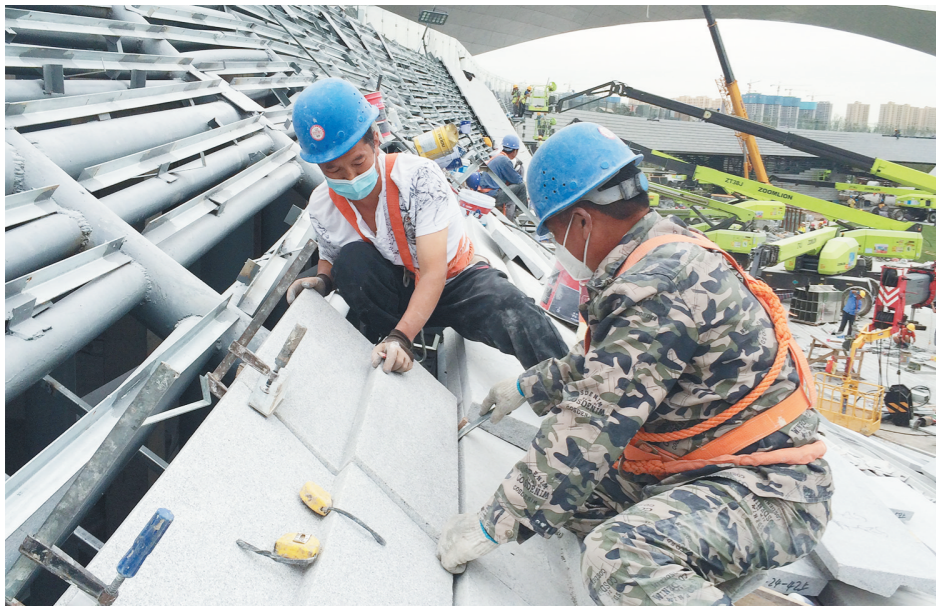
由陕建筑装饰集团承担装饰任务的“长安云”项目是十四运会配套工程,与长安花主会场相邻。为确保完工亮化,该集团组织精兵强将,昼夜施工,拼搏大干。图为工人在钢架龙骨上铺贴流水幕墙的石材。 王雄文 何旭 摄
