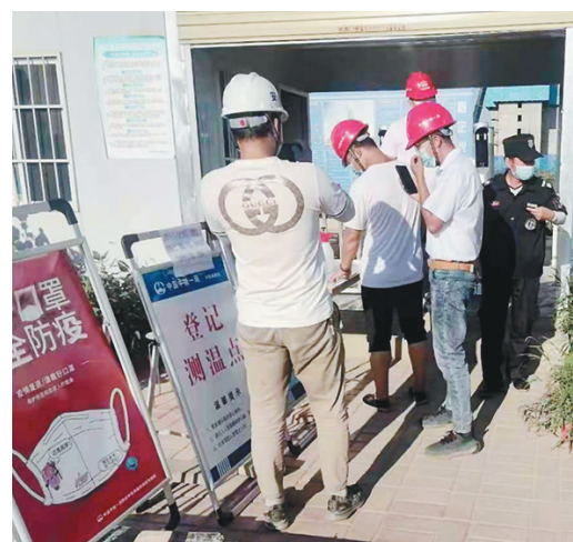
9月以来,中铁一局建安公司西安建筑分公司机关和项目部积极通过多种方式做好防疫工作,助力十四运会,展现中铁人风采。图为中铁卓越城项目对进入施工现场人员进行测温扫码登记。 □徐晓棠 焦娟萍 杨晓芳 摄
