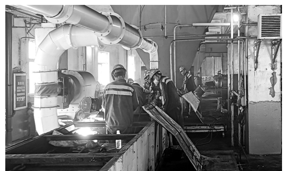
为了确保生产设备平稳运行,近日,建设集团洗选煤运营公司红柳林洗煤厂项目部开展系统大修,检修工按照检修操作流程和安全生产措施,全面开展设备维修更换工作。图为检修工为3302刮板机更换底板。师荣荣 摄
