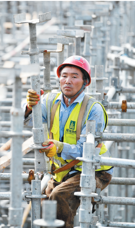
10月1日,中建三局西北公司员工在西安地铁16号线一期工程施工现场工作。 新华社记者 张博文 摄
