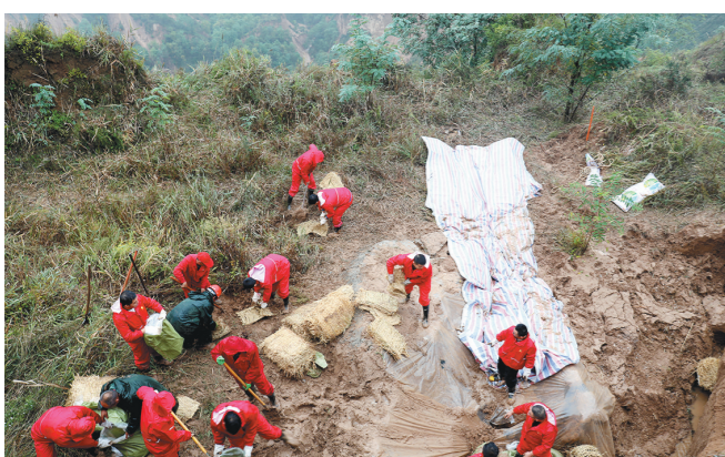
连日来,长庆油田采油一厂所属生产区域基础设施及道路水毁严重,该厂组织职工抢险,力争将影响降到最低。薛海 张建华 摄
