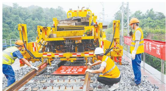
10月12日,中铁一局施工人员使用国内首创的新型长钢轨智能牵引车将最后一对500米长钢轨精准铺设在道床上,标志着中(国)老(挝)昆(明)万(象)铁路全线铺轨完成,实现国内与国外连通,向着开通运营目标迈出了重要一步。
