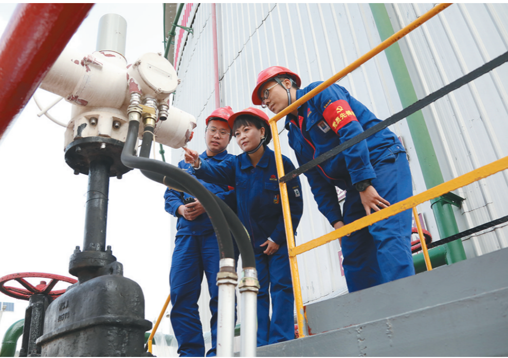
为切实做好冬季场站管道、机泵和储罐设备安全管理工作,延长石油管道运输公司第二分公司永坪输油末站抓
