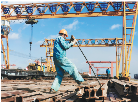
11月3日,中老铁路建设施工进入尾声,中铁路一局玉溪段和铺架基地到处一派繁忙景象。图为工人正在施工。 刘顺良 摄
