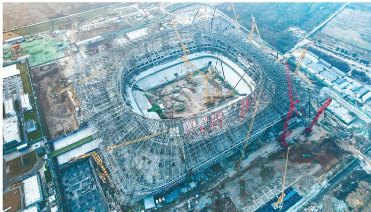
11月21日航拍的2023年亚洲杯主场馆——西安国际足球中心项目建设现场。随着总重7600吨的屋盖钢结构合龙,令人震撼的主体形象逐渐呈现。该场馆屋盖钢结构南北295.6米、东西250.6米。项目设计满足足联和国际足联标准要求,可承接国际一流足球赛事。 冯彩丽 摄
