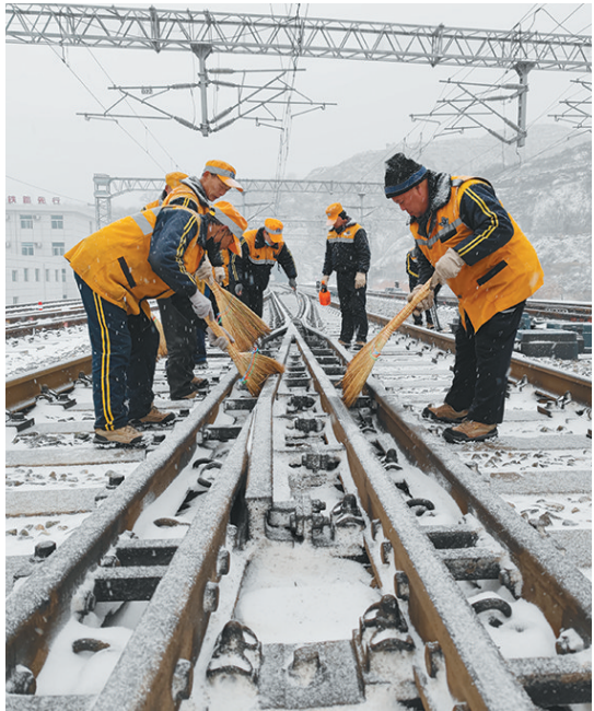
延安工务段职工在包西线黄陵南站区进行道岔扫雪作业。 □穆旭东 摄
