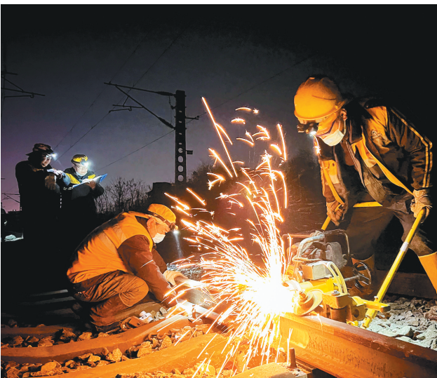
安康工务段职工在襄渝线进行铝热焊接和钢轨打磨作业。 □张霖 摄
