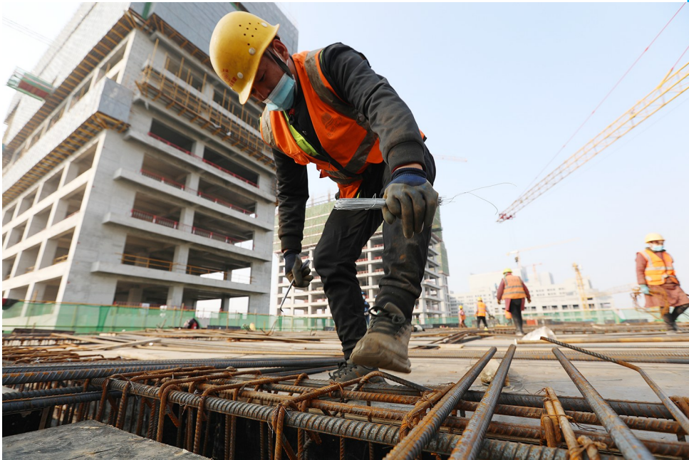
2月9日,工人在中建五局承建的西安电子谷FGH区项目进行钢筋捆绑作业。目前近300名工人加紧施工,确保项目建设进度。 本报记者 鲜康 摄
