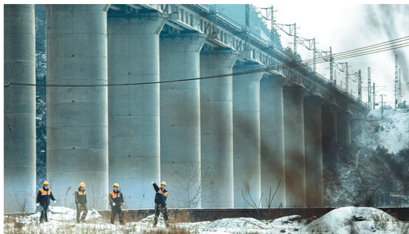
在石泛河大桥的背景下,巡视人员显得格外渺小。
