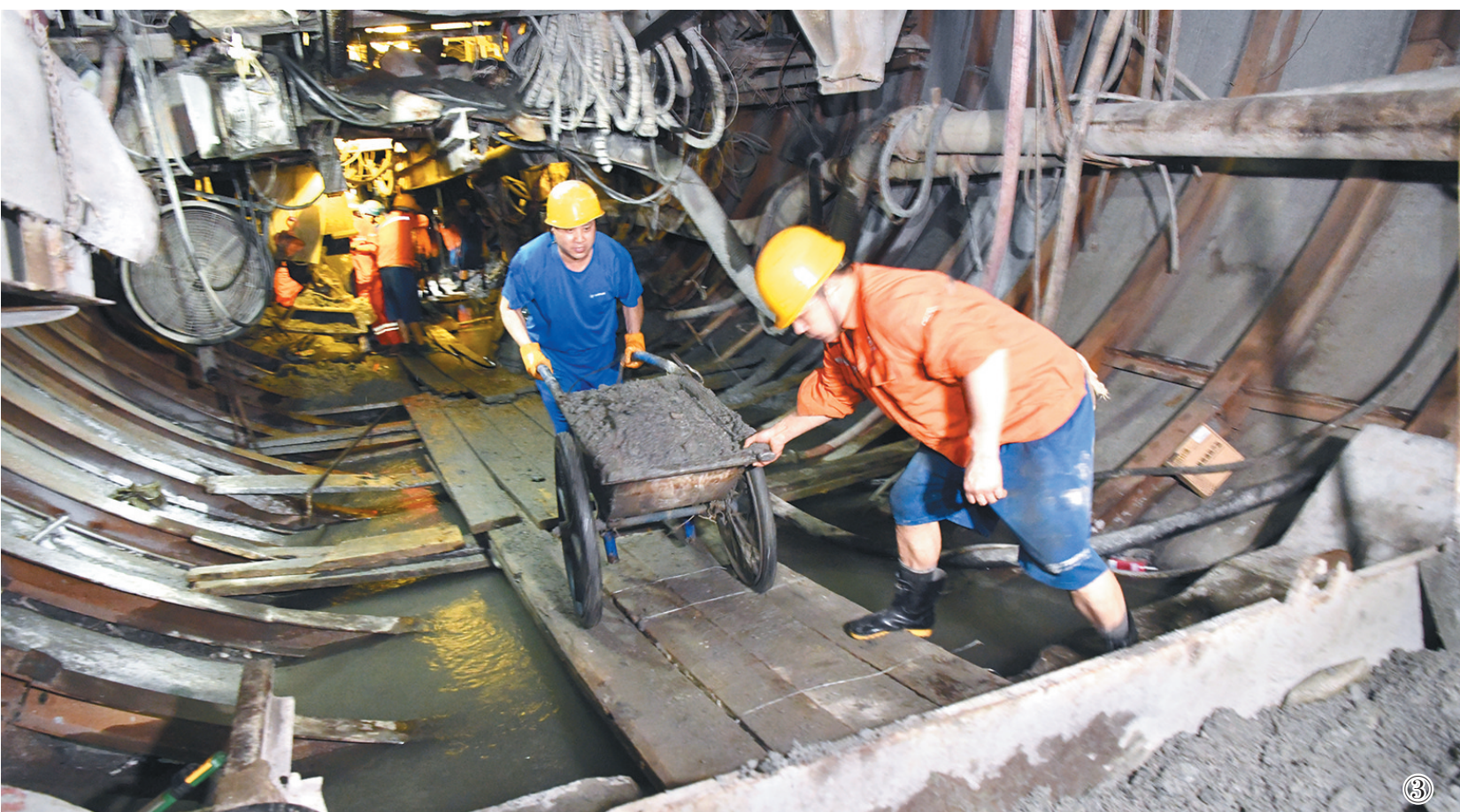
③在TBM掘进机作业区域,建设者清理残渣。本报记者 刘强 摄
