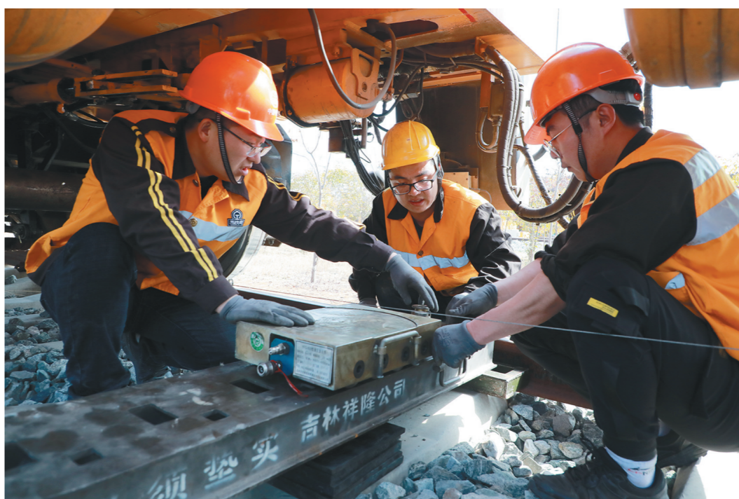
近日，中国铁路西安局集团西安工务段综合机修车间组织党员突击队，举行捣固车起复应急演练，进一步提高应急处置能力和标准化作业水平。 □马小妹 摄
