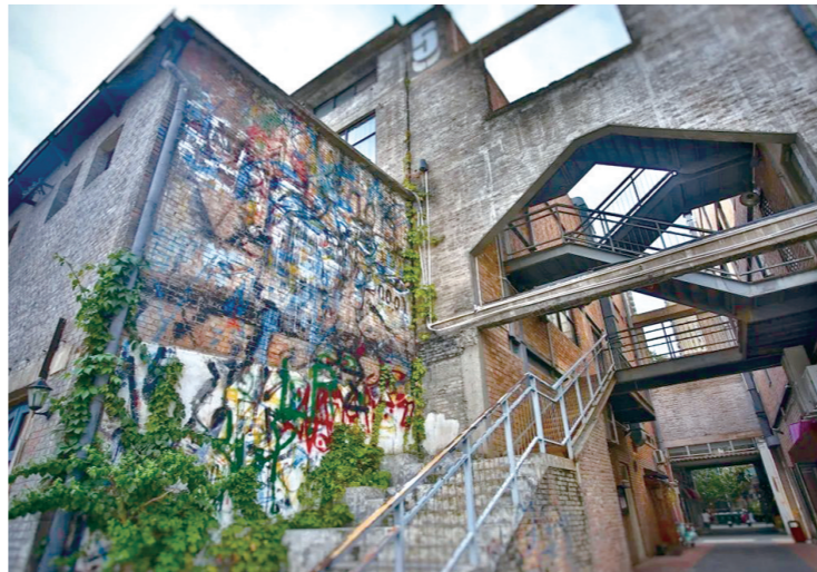
园区内的钢铁楼梯。
