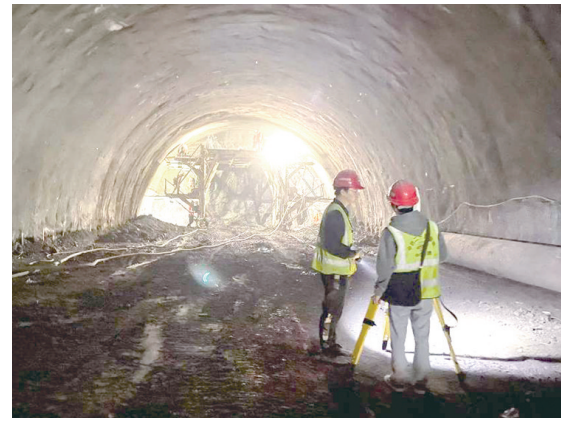
3月24日,在中铁二十局承建的渝湘复线彭酉高速五标建设工地,施工人员正按操作流程高标准施工。图为测量人员在两臂隧道开挖线放线。
