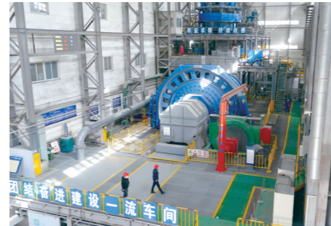
该公司百花岭选矿厂车间在进行磨矿作业(4月7日报)。
