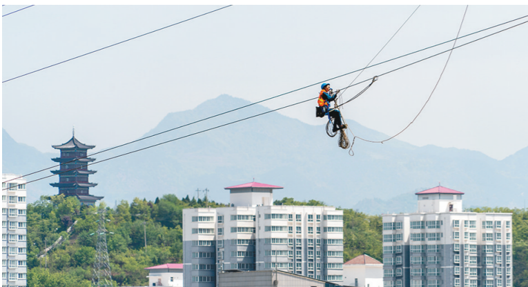
近日,国网商洛供电公司动员60余名职工,对位于商州区杨峪河镇四合村的35千伏商黑线3号铁塔进行迁移,用带电作业的方式成功转接用电负荷,实现了线路迁改期间完全不间断供电。 □祝赫 摄
