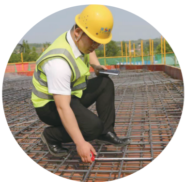
王成在现场测量钢筋间距。
