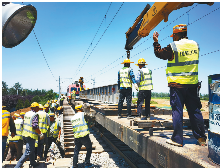
面对近日高温天气,陕西西工工程建筑有限公司制定“一项一案”安全卡控措施,严格落实施工作业标准。图为施工人员在安全员的指挥下进行架梁拆除作业。 □田家卫 摄
