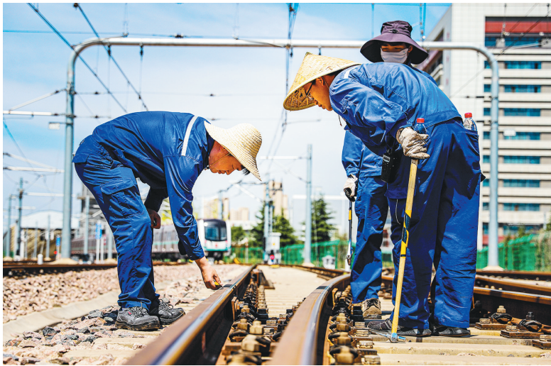
6月19日,西安地铁4号线航天城车辆段,线路工对钢轨设备状态进行几何参数测量。6月中旬以来,西安地铁对露天钢轨设备进行维护,为夏季高温下的安全运营提供有力保障。
