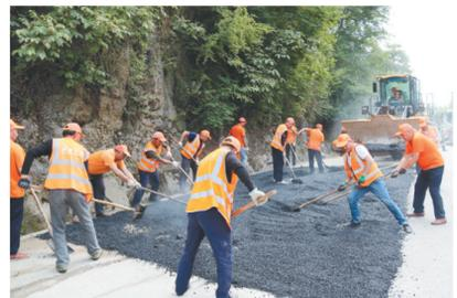
连日来,汉中市巴公路段抢抓天气晴好有利时机,采取人工与机械相结合的方式,全面组织开展路面坑槽修补工作。
