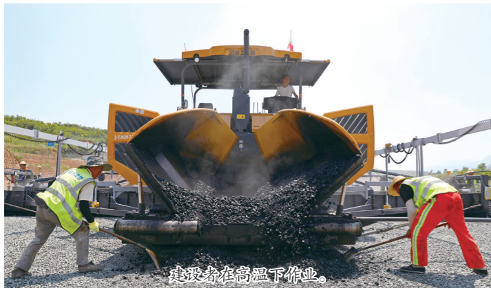
建设者在高温下作业。
